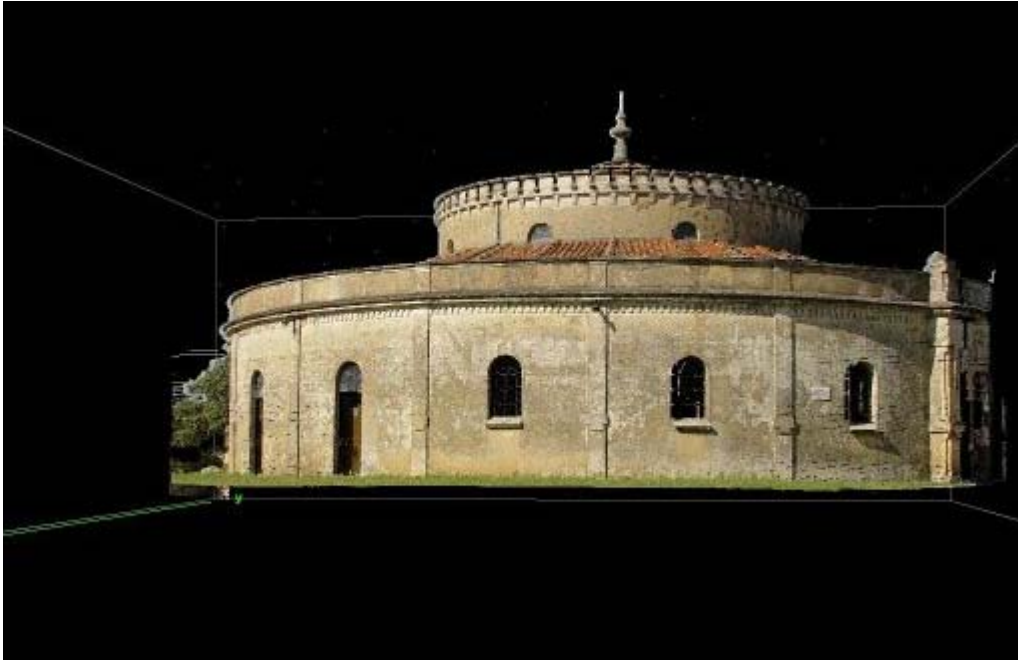
FIGURA 6 - Fachada oeste do teatro do Paiol
