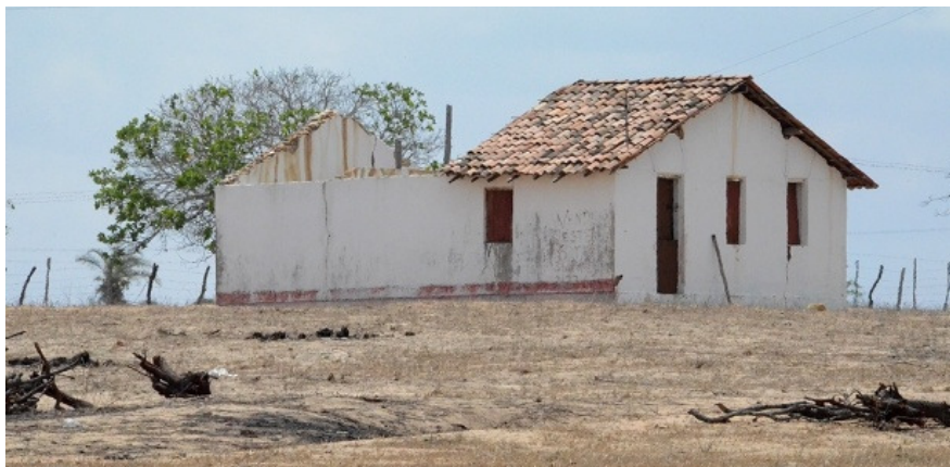
Casas abandonadas no sítio Vargem Comprida são comuns
